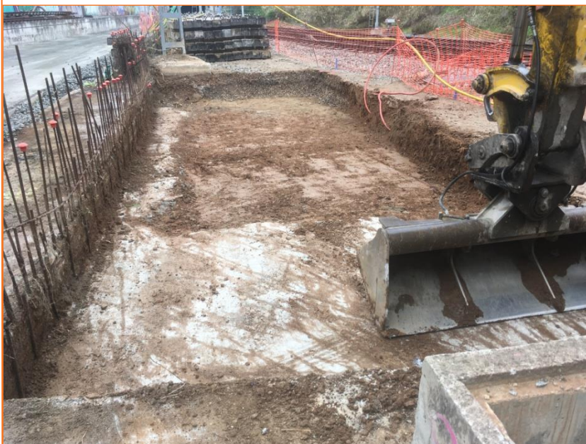
Foto 4. Vista final de la zona dels rebaixos a la capçalera sud. Fase 1.
