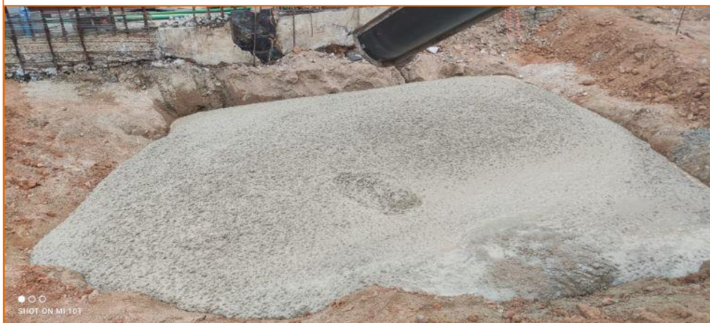
Foto 24. Formigonat del sondeig 1. Fase 3.
