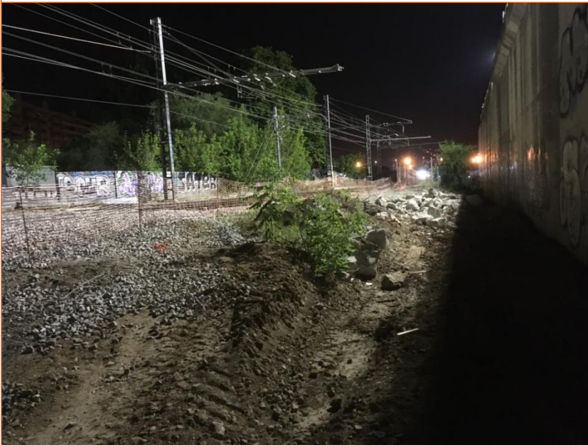
Foto 11. Vista inicial abans de començar els rebaixos al subsòl a la capçalera nord. Fase 2.
