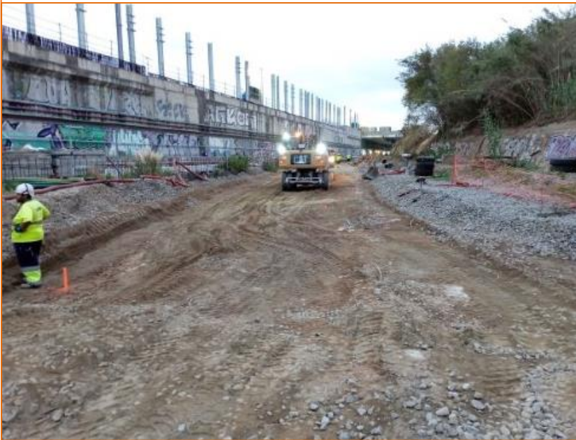
Foto 19. Rebaix inicial del caixó d'obra. Fase 3.
