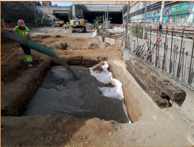
Foto 35. Formigonat del sondeig 2. Fase 3.
