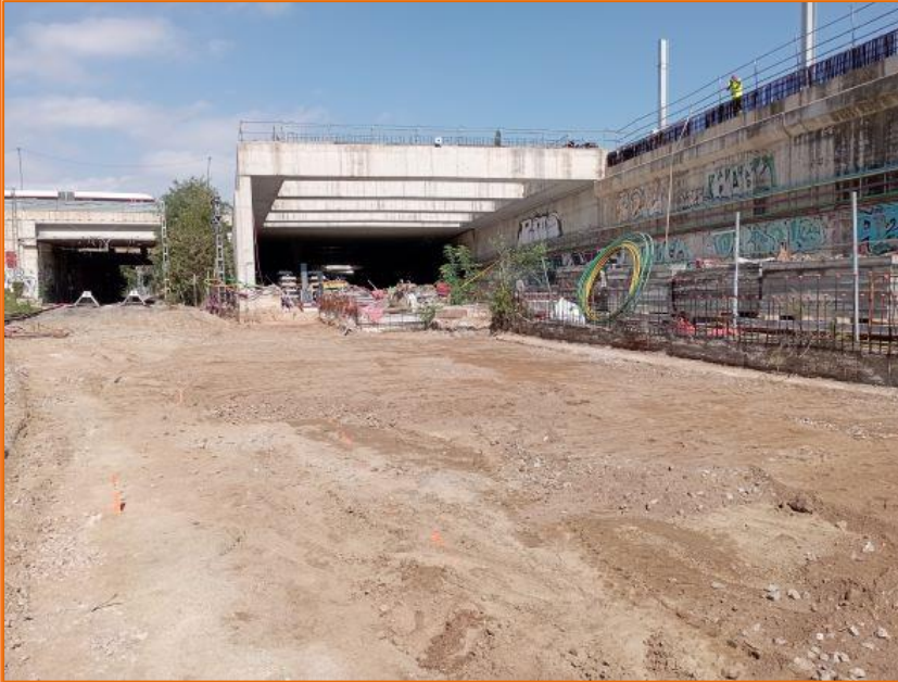
Foto 17. Rebaix inicial del caixó d'obra. Fase 3.
