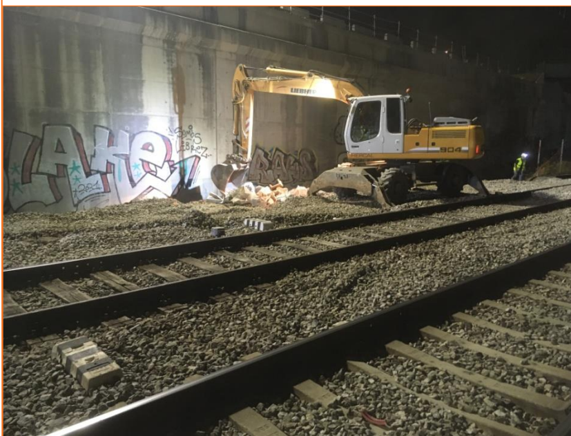
Foto 12. Vista de l'inici de l'excavació de la UE 1. Fase 2.
