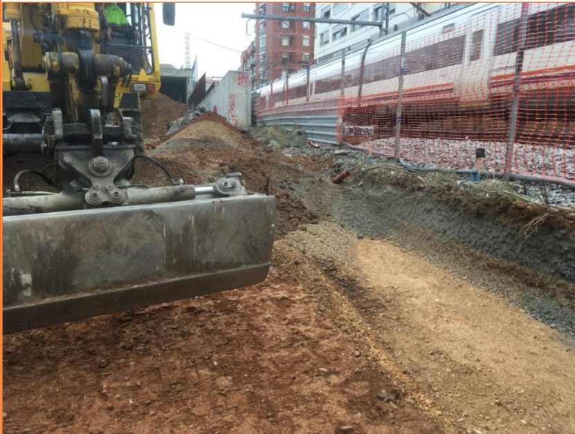
Foto 7. Vista dels treballs d'excavació, retall UE 2 i nivell UE 3. Fase 1.
