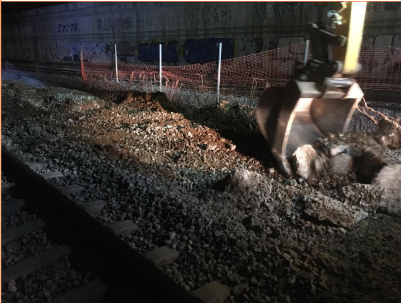
Foto 13. Vista de l'excavació del balast (UE 1). Fase 2.
