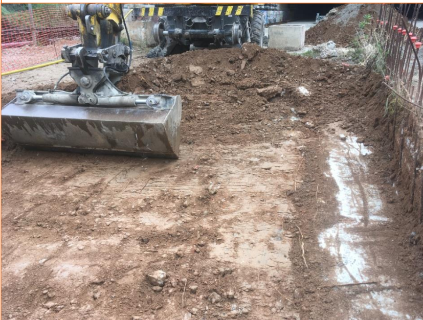
Foto 2. Vista de l'excavació de la UE 1 en la capçalera sud. Fase 1.
