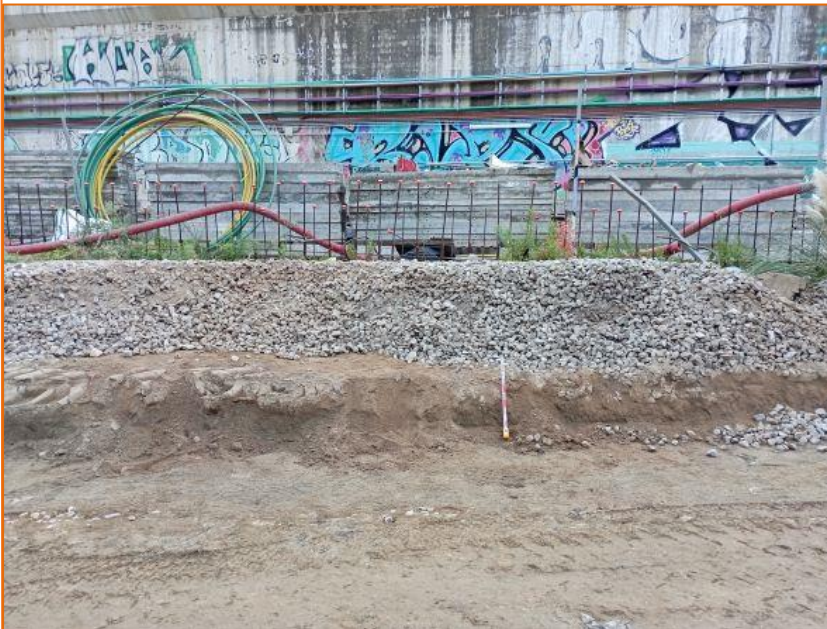
Foto 18. Rebaix inicial del caixó d'obra. Fase 3.
