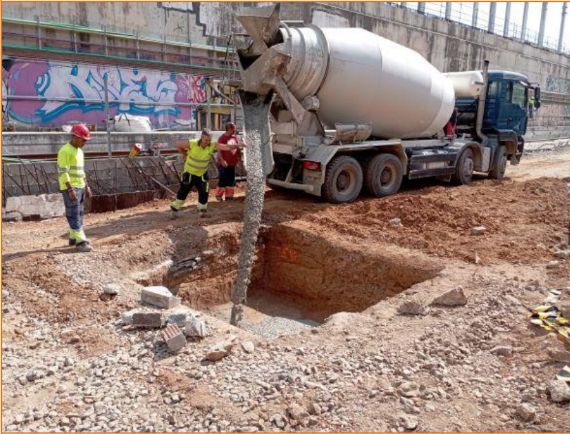
Foto 43. Vista del formigonat del sondeig 3. Fase 3.
